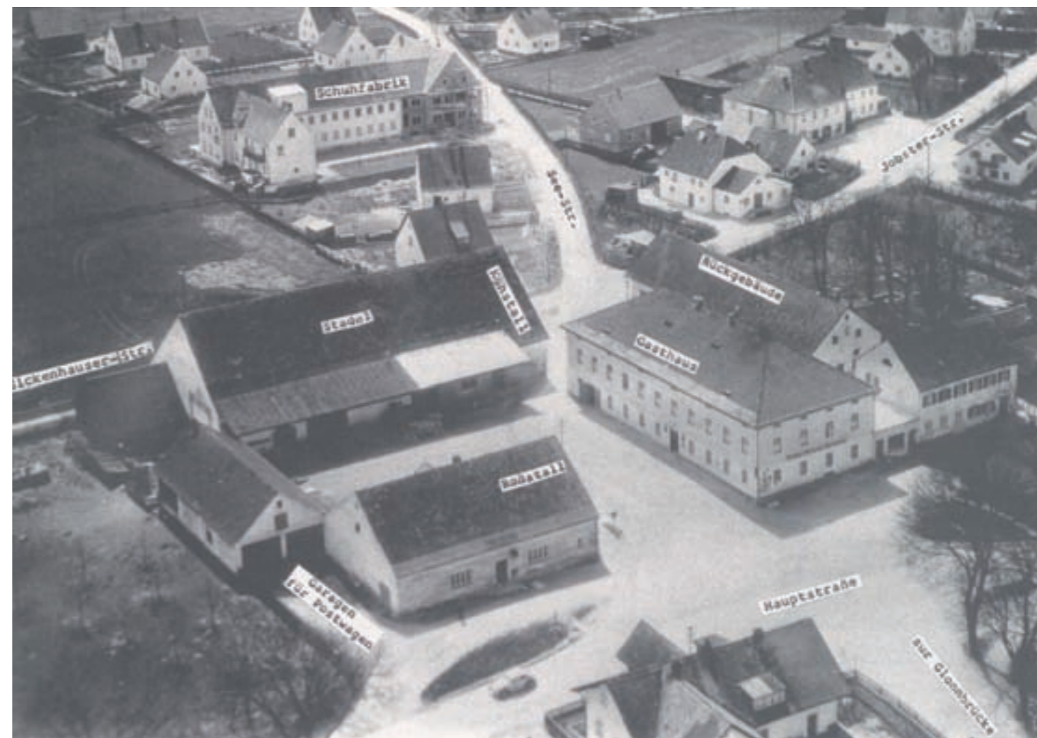
▲ Dorfzentrum mit Schuhfabrik Völkl
